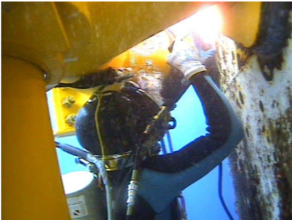
Installing the Habanero Llano Dual I Tube
